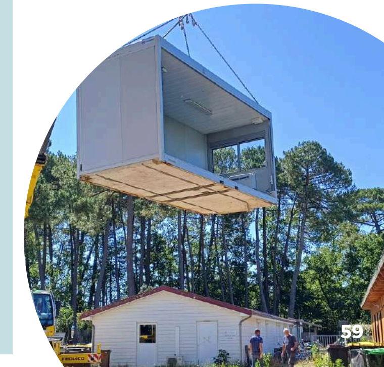
Dépose des modulaires
