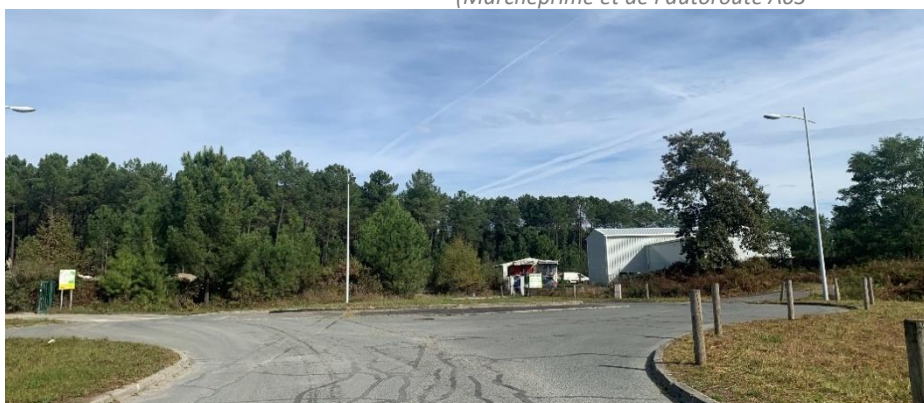
Futur accès interne au site via la rue de Galeben et son rond-point, qui dessert déjà des activités économiques implantées sur la droite, implantées dans l’actuelle zone UY
